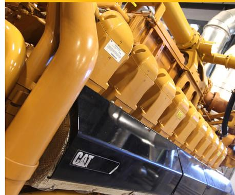
Установка для комбинированного производства тепла и электроэнергии EBI Énergie закачивает 4500 стандартных кубических футов метана в минуту в шесть газовых генераторных установок Cat® G3520C, преобразующих газ в электричество.
