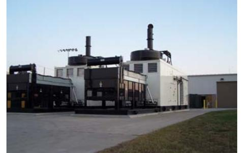
Генераторные установки G3520E и G3516H установлены в корпусах для наружного применения. Сооружение на заднем плане вмещает все механическое и электрическое оборудование, необходимое для параллельной работы установки и электрической сети центра LEC.
