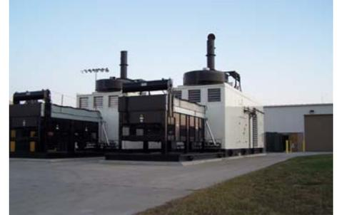
*os grupos geradores G3520E e G3516H estão alojados em compartimentos externos. O prédio no plano de fundo abriga toda a infraestrutura elétrica e mecânica necessária para operar em paralelo com a alimentação da instalação elétrica do LEC.*
