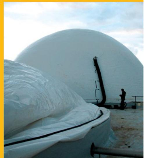
Usando a tecnologia de biodigestão agrícola de dois estágios, a Seacliff transforma resíduo animal e vegetal em calor, eletricidade e fertilizante natural.
