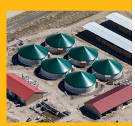
Para atenuar os odores, a Bettencourt Dairies instalou seis digestores anaeróbicos de um milhão de galões no local para processar adubo na Rock Creek Dairy.
