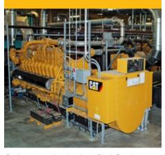
O gás metano é coletado da Rock Creek Dairy e canalizado em dois grupos geradores a gás Cat<sup>®</sup> 3520C que convertem o gás em eletricidade, que é, em seguida, vendida à Idaho Power Company para distribuição à rede elétrica principal.
