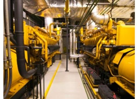
Rochavera 综合楼的 CHP 系统由四台 Cat G3520C 燃气发电机组供电，每台额定功率为 2055 kW，还准备了两台功率为 1500 kW 的 Cat 3512B 柴油发电机组，以供备用或用电高峰使用。该系统可提供 11.2 MW 的电能，并为总共 15.7 MW 的能量提供相当于 4.5 MWeq 的冷却容量。
