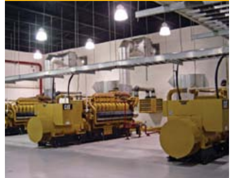
三台卡特彼勒 G3520C 高压发电机组功率均为 2050 ekW。
