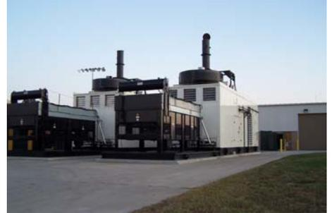
G3520E 和 G3516H 发电机组置于室外机装箱中。背景建筑中安置了与 LEC 市政供电网并联所需的整个电力和机械基础设施。
