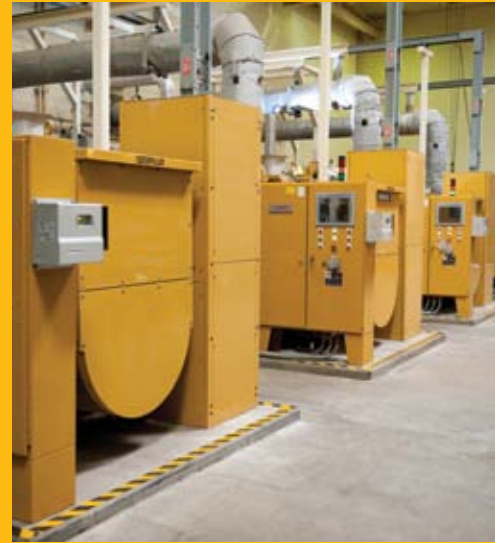
恩西纳水污染控制厂 (EWPCF) 在处理废水中产出的沼气供四台卡特® G3516
