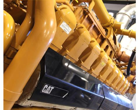
EBI Énergie 的热电设备每分钟向六个 Cat® G3520C 燃气发电机组泵出 4500 标准立方英尺的甲烷，将燃气转化为电能。
