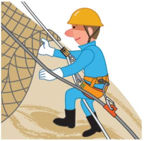
「ロープ高所作業」とは、高さ2m以上の場所で作業床を設けることが困難な場合に、昇降器具(ロープに身体を保持する器具を取り付けたもので、作業員が自らの操作により昇降する)を用いて行う作業を指します。ビルや橋梁のメンテナンス、法面保護工事などのロープ高所作業の現場では、命綱であるロープが切れたり、結び目がほぐれたりして墜落する事故がこれまで多発していました。そこで、厚生労働省では、ロープ高所作業の危険防止に関わる規定を新設するなど労働安全衛生規則の改正を行い(平成28年1月1日施行)、また7月1日から、ロープ高所作業に就く労働者には「ロープ高所作業特別教育」の受講を義務付けています。
