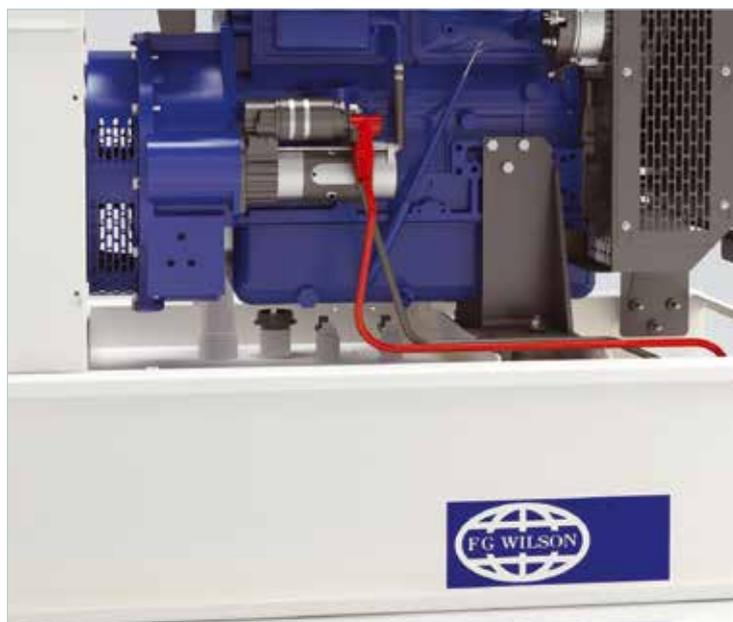
O conserto e a manutenção são rápidos e eficientes, com componentes de fácil acesso. Drenagem de óleo e de líquido refrigerante proporcionam acessibilidade para a manutenção conveniente, enquanto o bocal de abastecimento de combustível e o indicador estão posicionados juntos para facilitar o abastecimento e monitoramento,
