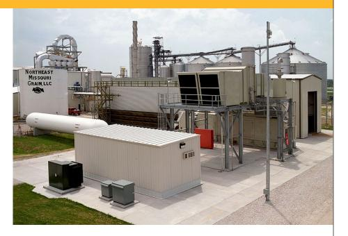
El alcance de los servicios provistos por parte de Solar incluyó la isla completa de electricidad, que consta de la turbina de gas, generador de vapor para recuperación de calor no encendido, y compresor de gas combustible. La turbina de gas *Mars* opera a 100% de carga base y está equipada con *SoLoNOx*<sup>TM</sup>, el sistema de combustión de bajas emisiones en seco de Solar, que se requiere para cumplir las estrictas normas para emisiones de gases.
