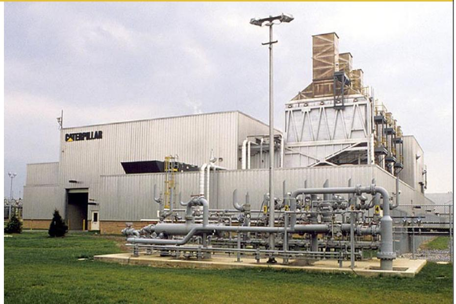
de vapor, que también se usa para alimentar el sistema de calefacción de la planta y cubre los requisitos de fabricación de la planta de Caterpillar. El vapor se conduce a la sección de alta presión de los dos generadores de turbina de vapor. A continuación se extrae entre 10 900 y 72 600 kg/h (24,000 a 160,000 lbs/h) de vapor para la planta manufacturera y el vapor restante se puede expandir a
