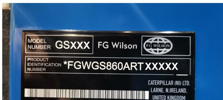
Figura 3.1 – Placa PIN Típica
