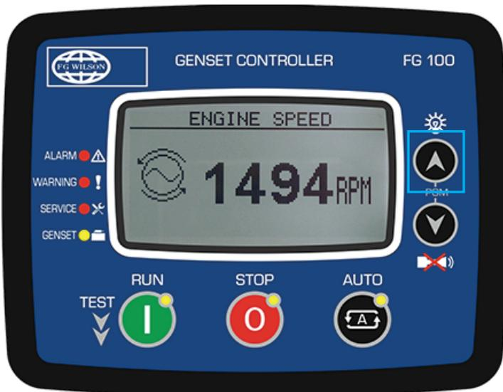
编程模式用于调整计时器、操作限值和控制器的配置。虽然提供用于编程的免费PC程序，但是，无论运行模式如何，均可通过前面板修改每个参数。
