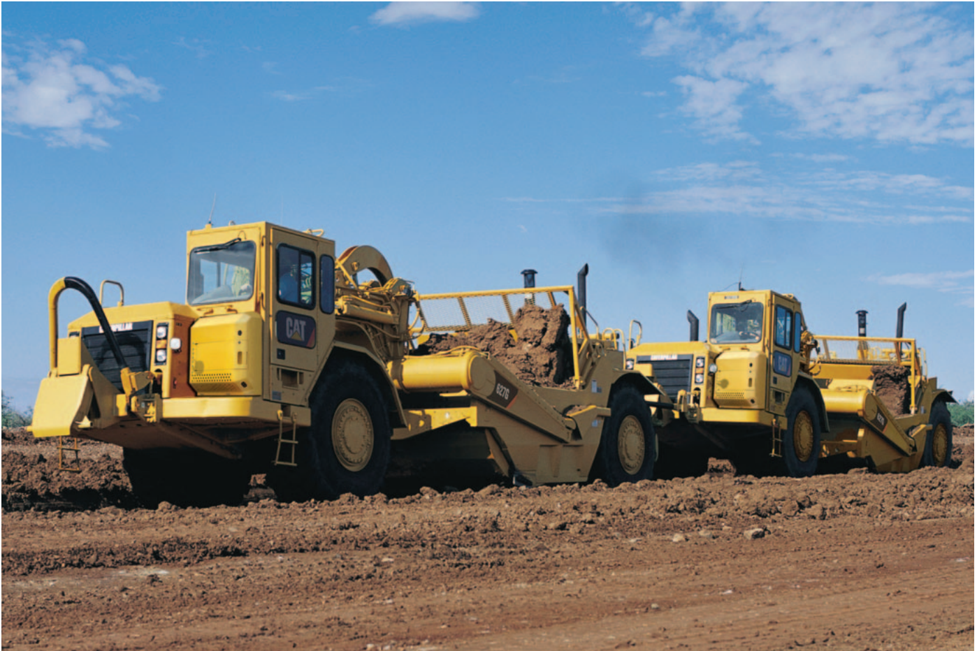
La operación estándar de empuje y arrastre mediante el uso de máquinas 627G gemelas.
