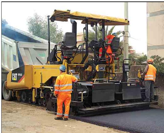
*La anchura de pavimentación del reglón AS4251C es de 2550 a 5000 mm. Equipado con extensiones mecánicas a ambos lados puede llegar a proporcionar una anchura de pavimentación máxima de 8000 mm.*
