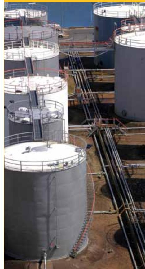
出了炼油厂的燃油被船舶、输油管、驳船和卡车运往偏僻地区，期间通常储存在中间储油罐内（如上图所示）。每次储存或运送过程都有可能造成燃油污染。在某些情况下，水和/或污物的总量可能会对燃油造成污染。
