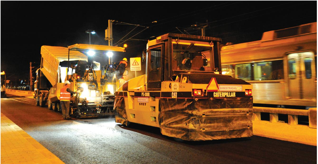
Cat® PM102. Ce modèle, plus petit que la Cat PM200, a été choisi pour sa taille, plus appropriée pour une route étroite. Heureusement, le rendement de la machine fut largement suffisant pour raboter une voie de circulation en seulement deux nuits.
