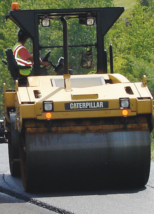
^ Eine 2-Meter – Walze von Cat® arbeitet in der heißesten Temperaturzone vor der Weichphase.
