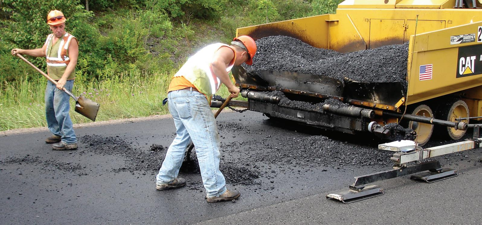
^ La siguiente unidad de arrastre debe sujetarse y mantenerse lejos de la parte delantera de la extendidora mientras los trabajadores están limpiando los derrames.
