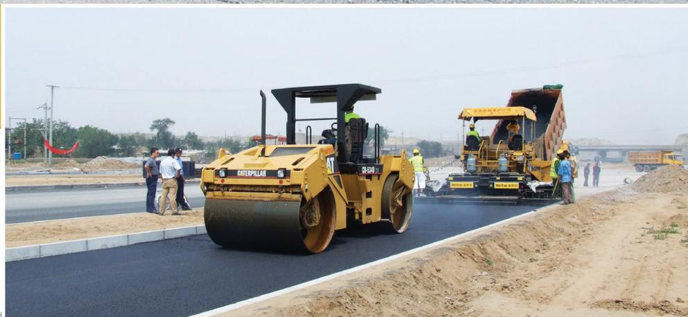
de 2520 vibraciones por minuto con un factor de eficacia del 75%, el compactador alcanzaría la velocidad de la extendidora trabajando a 70 mpm (229 fpm).
