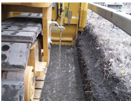
Le tambour de 2,2 m de large a permis de fraiser les chaussées de l'autoroute E78 en 4 passes contre 5.
