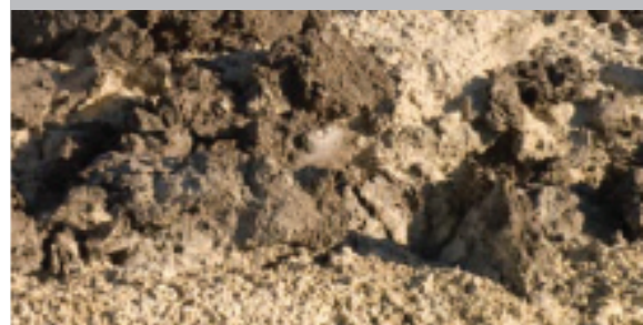
✓ Eine Ansicht des Bodens nach dem Reißen und vor dem trockenen Fräsdurchgang.
