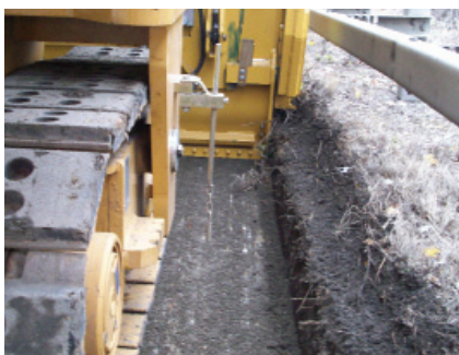
⚡ Die 2,2-m-Walze ermöglichte den Fräseinsatz auf der E78 in vier statt fünf Übergängen
