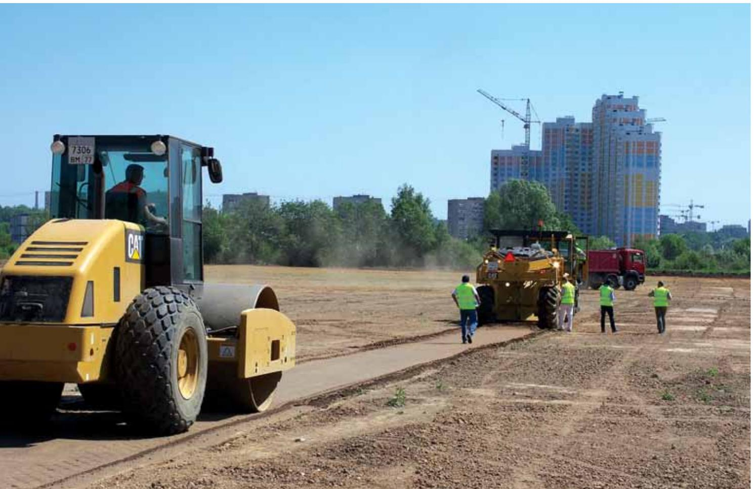
▲ La stabilizzatrice Cat® RM500 sull'area di 30 ettari vicino a Mosca, seguita dal compattatore vibrante monotamburo Cat CS533E.
