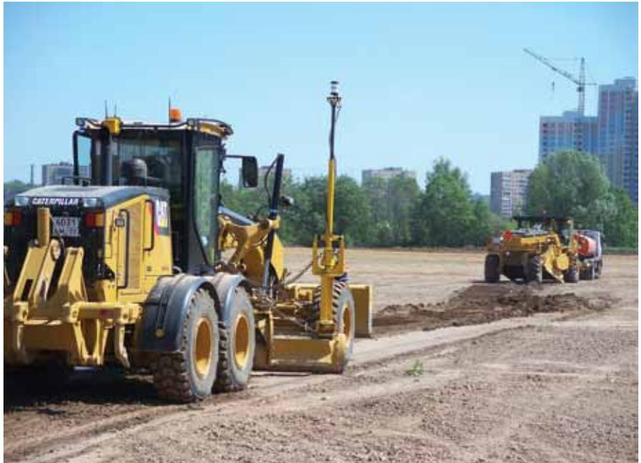
▲ La stabilizzatrice RM500 e l'autocarro che la rifornisce seguiti dal Motor Grader Cat®.
