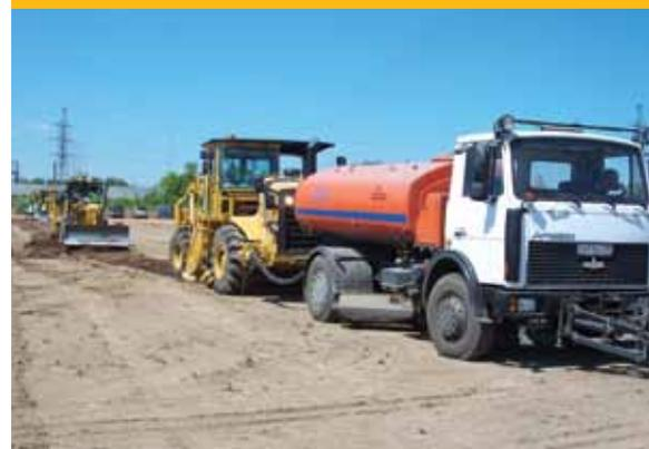
Un Motor Grader Cat® esegue interventi di profilatura dietro alla stabilizzatrice RM500 prima della compattazione.
