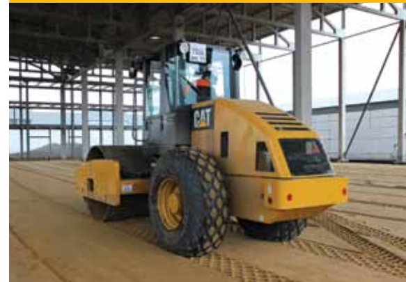
^ O compactador de solos CS533E em funcionamento num futuro depósito de armazenamento.
