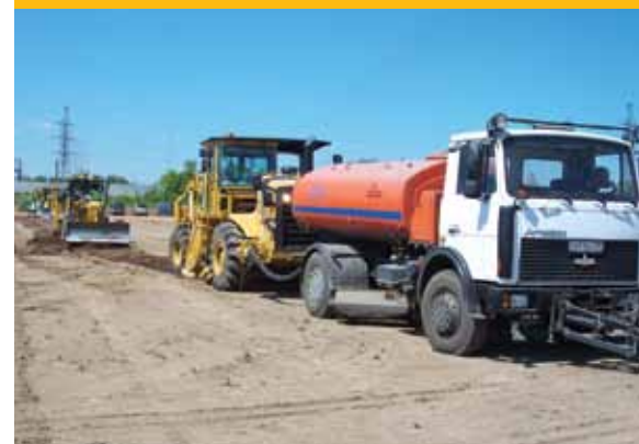
^ A motoniveladora da Cat® faz o perfil do local por trás da recicladora RM500, antes de realizar a compactação.
