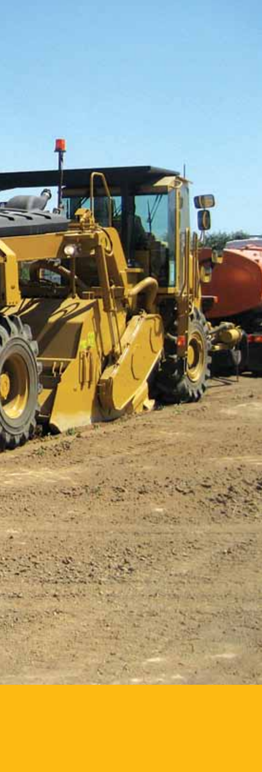
↗ A recicladora RM500 e o camião de alimentação são seguidos pela motoniveladora da Cat®.
