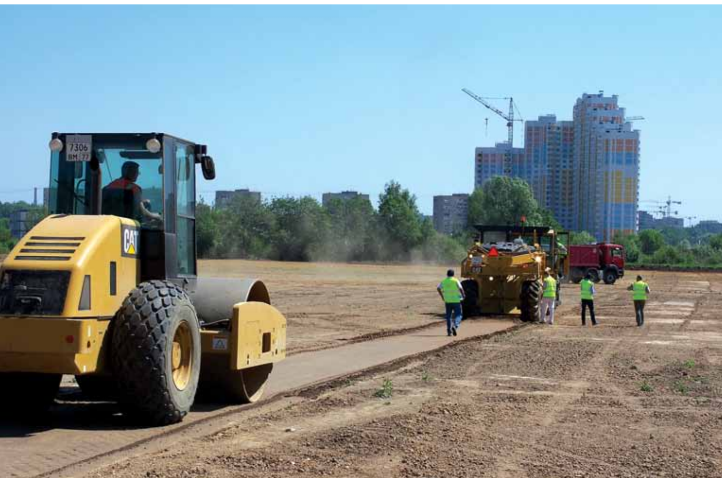
▲ A recicladora Cat® RM500, nas instalações de 30 hectares perto de Moscovo, é seguido pelo compactador de solos Cat CS533E.
