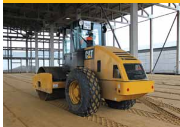
Le compacteur de sol vibrant CS533E à l'oeuvre dans un futur entrepôt.
