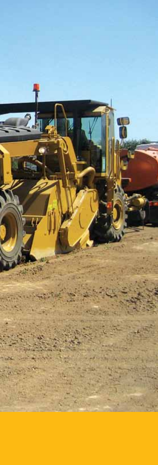
▲ La recycleuse-stabilisatrice RM500 et son tombereau sont suivis de la niveleuse Cat®.
