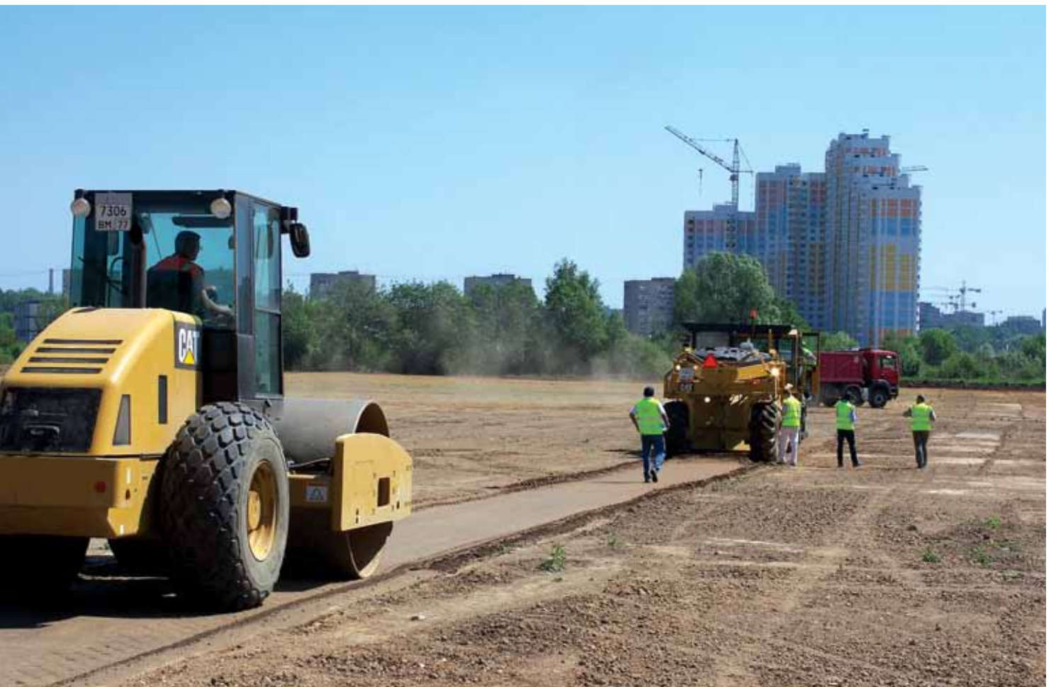
▲ La recycleuse stabilisatrice Cat RM500 sur le site de 30 hectares à proximité de Moscou, suivie par le compacteur de sol vibrant Cat® CS533E
