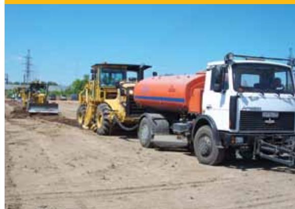
Une niveleuse Cat® profile le chantier derrière la recycleuse stabilisatrice RM500 avant le compactage.
