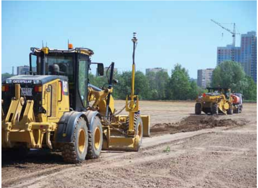
▲ La recycleuse-stabilisatrice RM500 et son tombereau sont suivis de la niveleuse Cat®.
