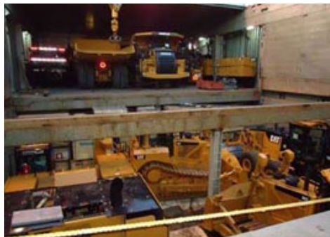
In einer kurzen Zeit mit Plusgraden im Sommer konnten die Maschinen die Baustelle erreichen.
