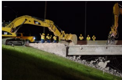
このダラス・フォートワース高速道路の再建工事は、先進国で必要とされるインフラストラクチャの改善例です。
