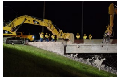
La reconstrucción de la carretera que une Dallas y Fort Worth es un factor representativo de la necesidad de mejorar la infraestructura en el mundo desarrollado.
