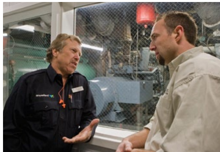
El personal de Snowbird sigue un estricto programa de mantenimiento para garantizar la longevidad de los generadores.
