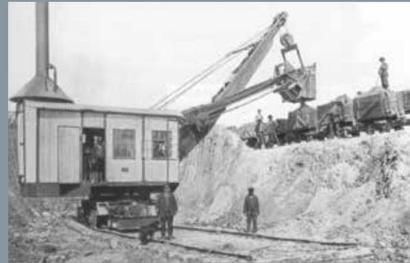
Une grande partie des grandes pelles ferroviaires à vapeur du 19e siècle furent montées sur des chenilles ou converties de la sorte dans les années 1920. Ce montage sur chenilles permit de réduire le temps moyen nécessaire au déplacement de la pelle de 9 minutes à 30 secondes. Les pelles à vapeur tombèrent finalement en désuétude dans les années 1930 avec le développement des pelles à moteur diesel, plus économiques.
