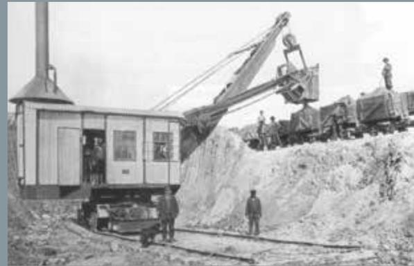
20世纪20年代，很多19世纪的大型蒸汽铁路专用铲安装到了履带式底盘上或是改装为履带式底盘。通过采用履带式底盘，铲具的平均移动时间从原来的9分钟减至30秒。随着更经济的柴油驱动铲的发展，蒸汽铲于20世纪30年代最终退出了历史舞台。
