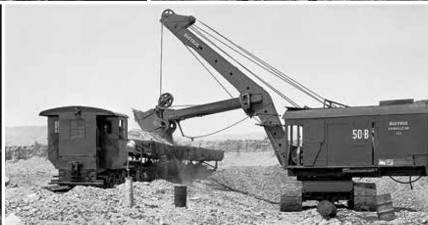
这种蒸汽铲是当今 Cat® 矿用铲的前身，在 19 世纪和 20 世纪初的公共工程中起着主要作用，是铁路和巴拿马运河建设的关键所在。很多蒸汽铲都是建造在有轨底盘上的，锅炉和发动机就安装在底盘上。最左侧的照片是在 1906 年美国总统西奥多·罗斯福 (Theodore Roosevelt) 访问巴拿马运河工地期间拍摄的。在这张照片中，他就坐在一部蒸汽铲上。
